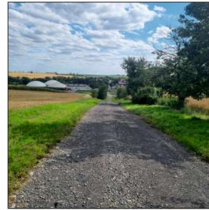
20 - Blick vom Wirtschaftsweg Richtung Süden zur Biogasanlage. Rechts im Bild Obstbaumreihe.
