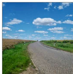
10 - Blick von der L 160 Richtung Norden. Beidseits der Straße Teile des Plangebietes.
