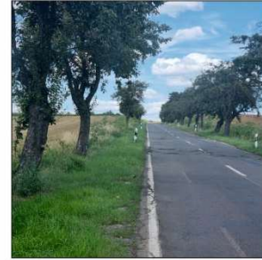
15 - Blick von der L 160 Richtung Norden. Beidseits der Straße große Obstbäume.
